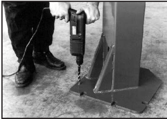
Fig.45 Foratura del pavimento
