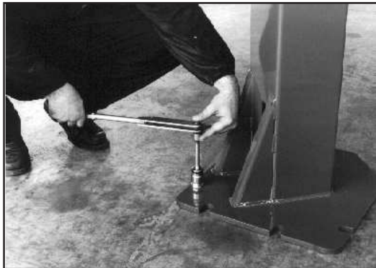
Fig.46 Fissaggio del basamento
